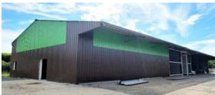
Transformation en cours des bâtiments Terrena en magasin
