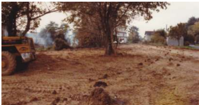
À la suite du nivellement de la ligne, on aperçoit à droite le dépôt de Mme Tranchant, face à son domicile, la maison de la gare
