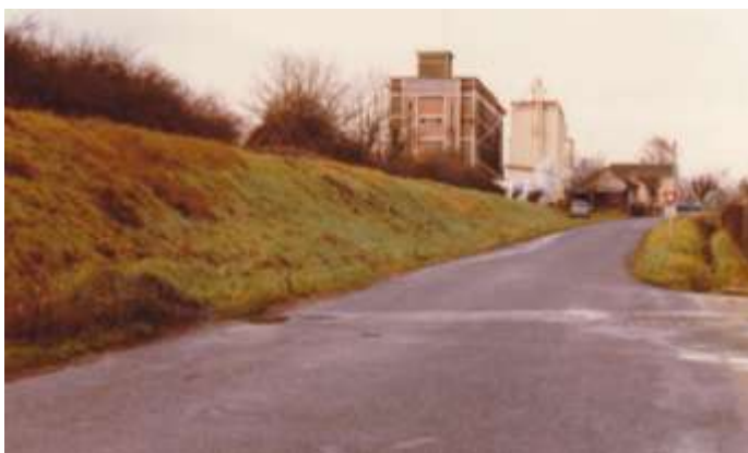
La ligne de chemin de fer avant les travaux
