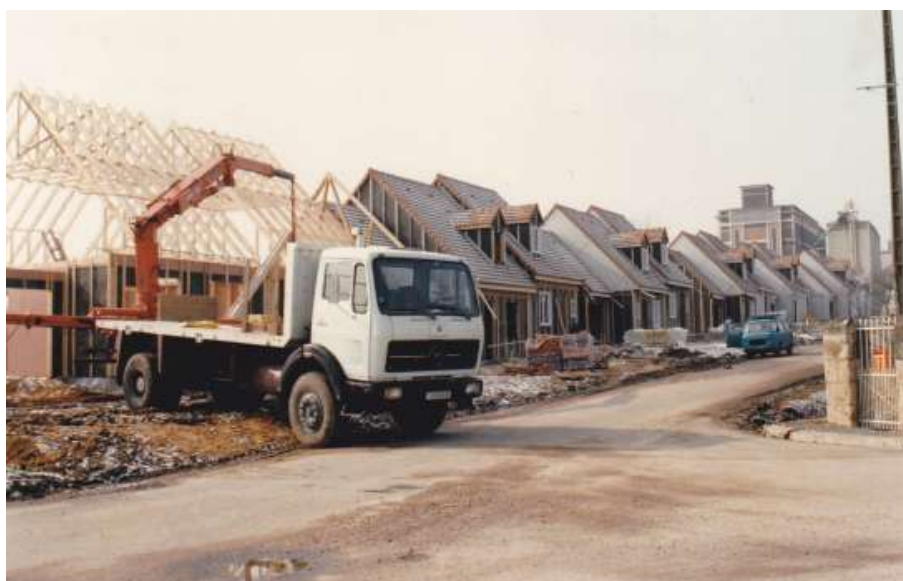
Construction des logements en 1986
