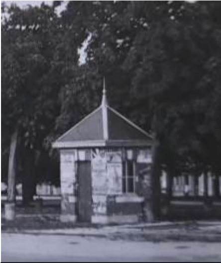
On aperçoit devant ce pavillon, le tablier de 4 m x 2,10 m
