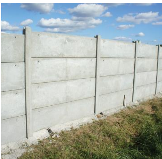
Exemple de plaques ciment lisses interdites.
