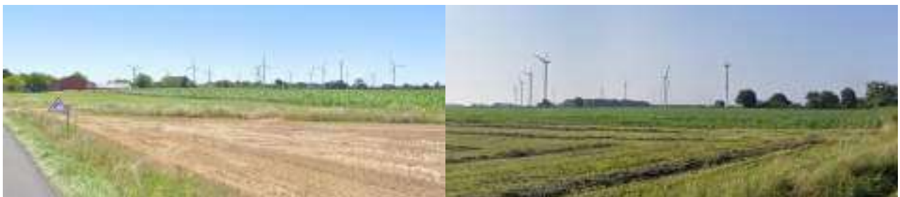
Photo 21. Vues du parc éolien de Saint-Pierre-de-Maillé depuis la D16 et champ de pignon (Google maps)
