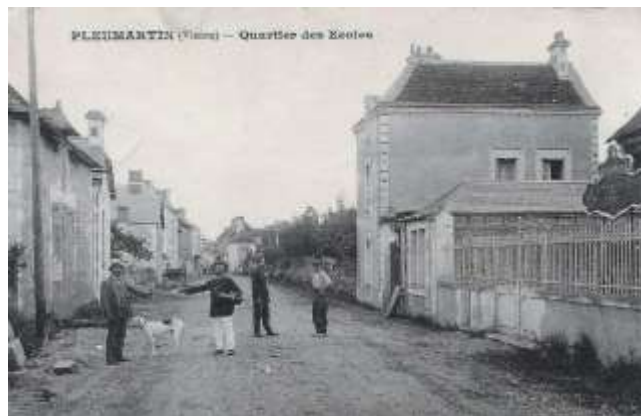
Photo de 1915 avec les grilles de l'école à droite et le panneau de la société de Tir, la Solidarité Pleumartinoise
