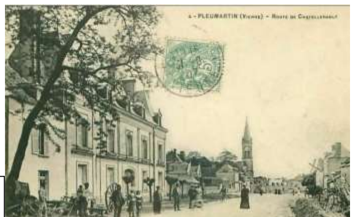
En 1907 – à gauche le grand bâtiment de Mr Hérault qui deviendra la gendarmerie en 1920
