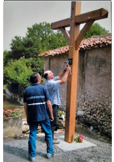
Mise en place de la nouvelle croix
