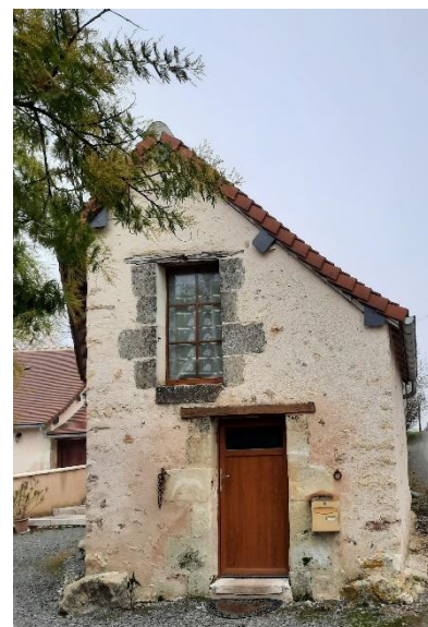
Une rénovation récente mettant en valeur le linteau bois et l'encadrement en vieilles pierres
