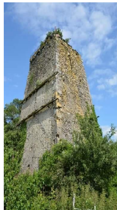
Vue actuelle du four à chaux
