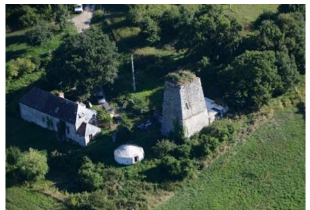
Vue aérienne du four à chaux de la Boissière
