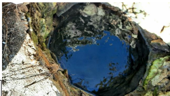
La source du lavoir
