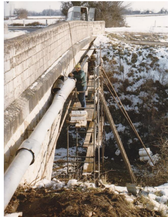
Rénovation du réseau d'eau potable en janvier 1987
